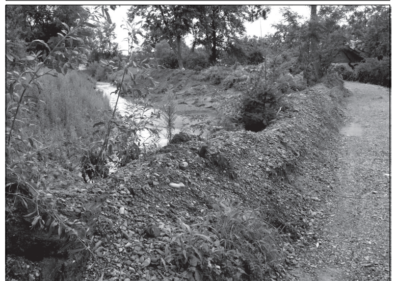
Дамба на найбільш небезпечній ділянці Волійці
